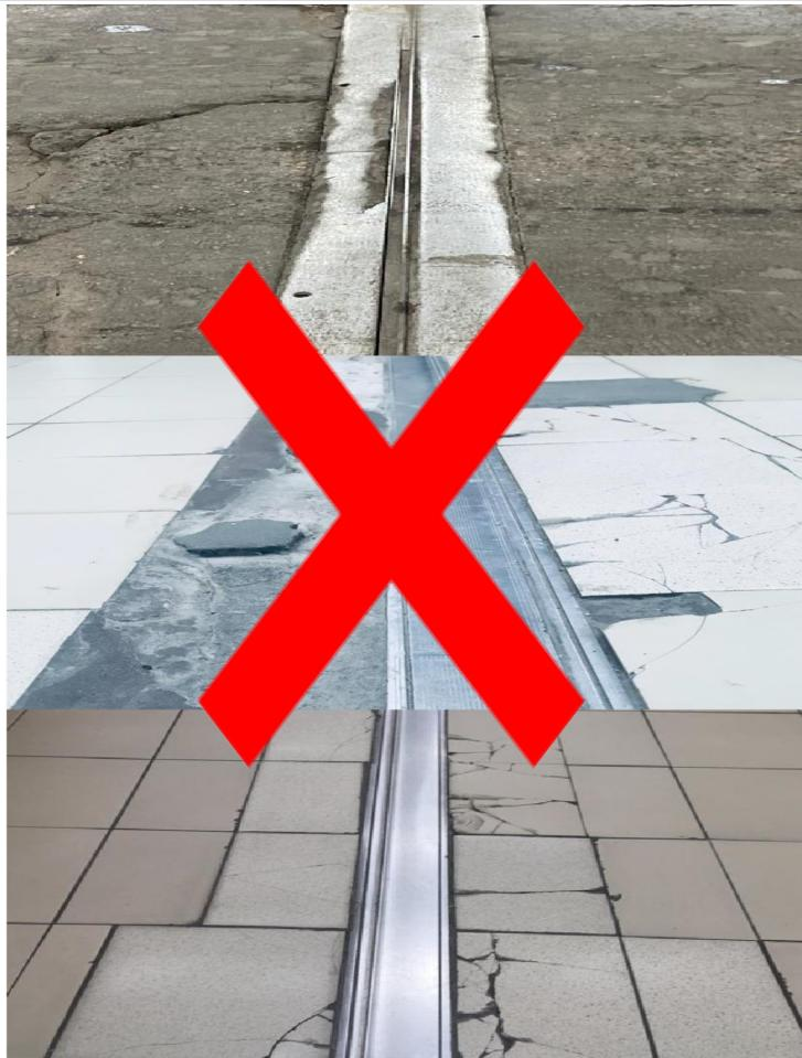
Не обеспечивает гидроизоляцию.
